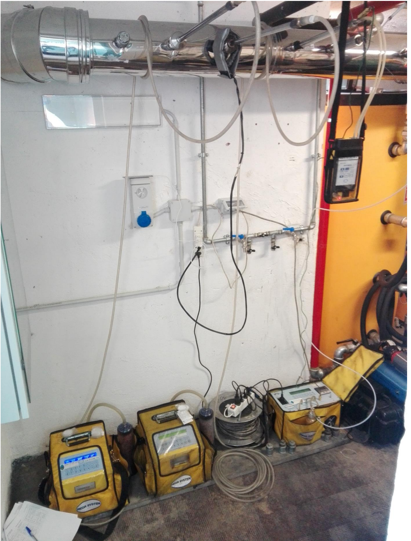
Figura 1: verifica delle emissioni in una caldaia a pellet
